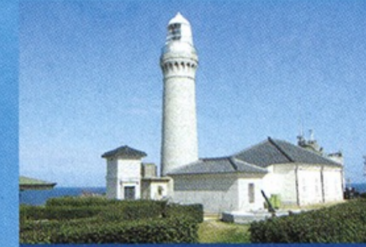
角島灯台 明治9年に初点灯した総御影石造りの洋式灯台で今なお現役で活躍しています。
